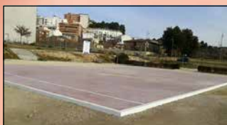
Construcción pista polideportiva en el Parque Manuel Carrascosa
