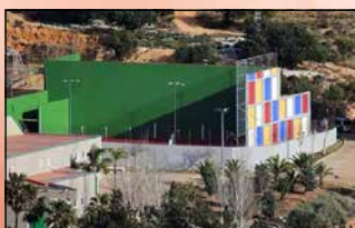
Mejora y adecuación de las pistas de Frontenis
