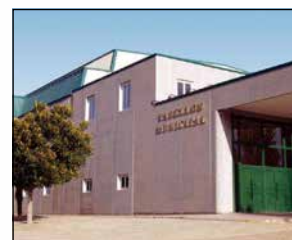
Mejora en las instalaciones del Pabellón Municipal de "El Planell"
