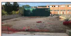
Arrancan las obras del parque de calistenia, pista polideportiva y zona de descanso en El Planell
